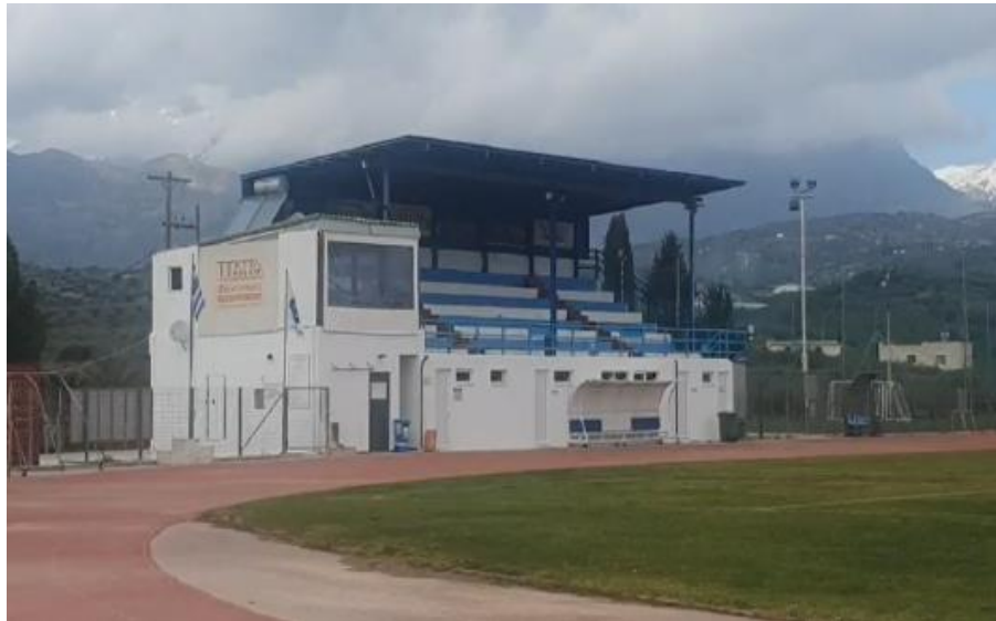
Εικόνα 2.2 Άποψη των υφιστάμενων κερκίδων (Ημερ/νία Λήψης: Φεβρουάριος 2023)
